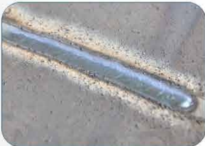
焊缝精密处理 Weld precision processing
